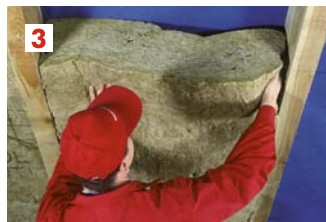
3. Укладка первого слоя утепления между стропилами
