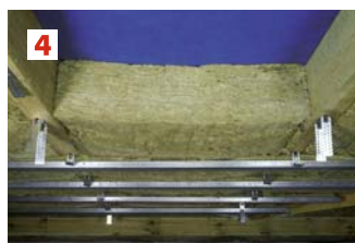
4. Монтаж стального каркаса
