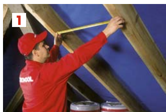
1. Измеряем расстояние между стропилами
