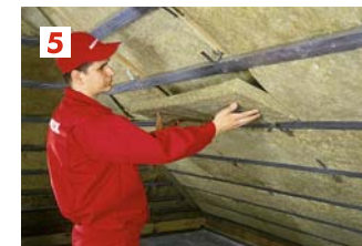
5. Укладка второго слоя утепления под стропилами
