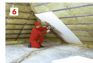
6. Монтаж пароизоляции (при необходимости) и облицовка мансардного помещения
